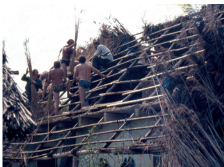
13. ábra. A vályogfalú Kalán-ház beázó nádtetőjének felújítása, 1980 (fotó: Sára János)
